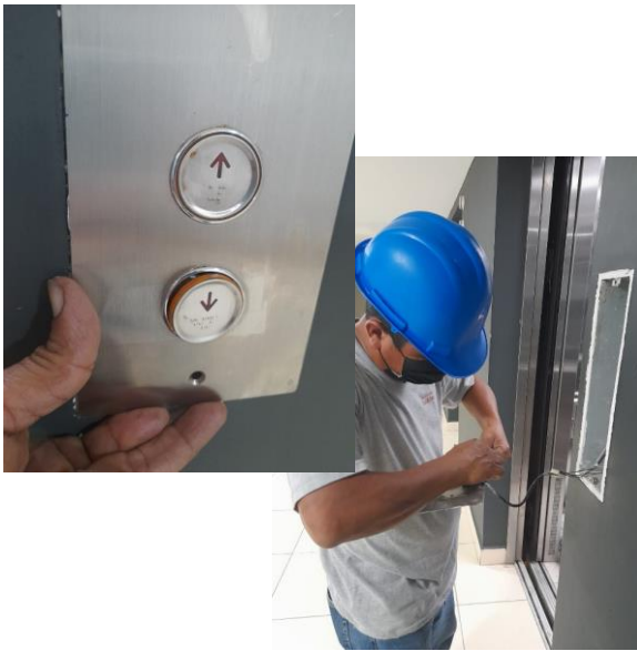
Reposición pulsador de bajada piso 23 ascensor 2.
